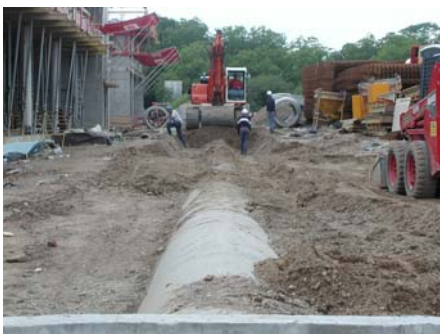
Rückhaltekanal SB DN 1200 (Drachenprofil) Nordseite
